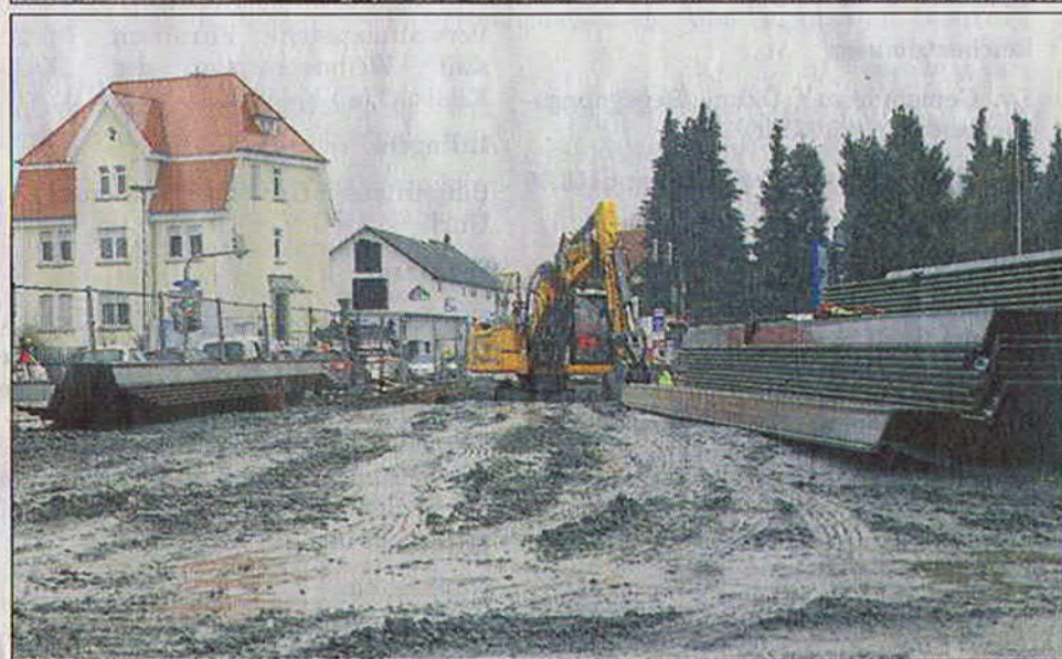
Baugrubensicherung in der Muthstraße mit Ramme (oben) und Bagger. Fotos: Tim Kegel
