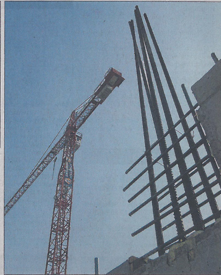
Große Kräne und eine riesenhafte Baugrube in der Muthstraße zeugen von Sinsheims spektakulärster Baustelle. Fotos: Tim Kegel
